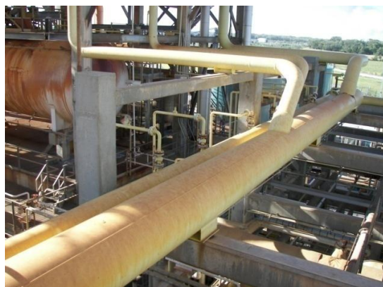
شکل ۱. لوله‌های متقاطع با درز جوش طولی در تأسیسات پالایشگاهی
